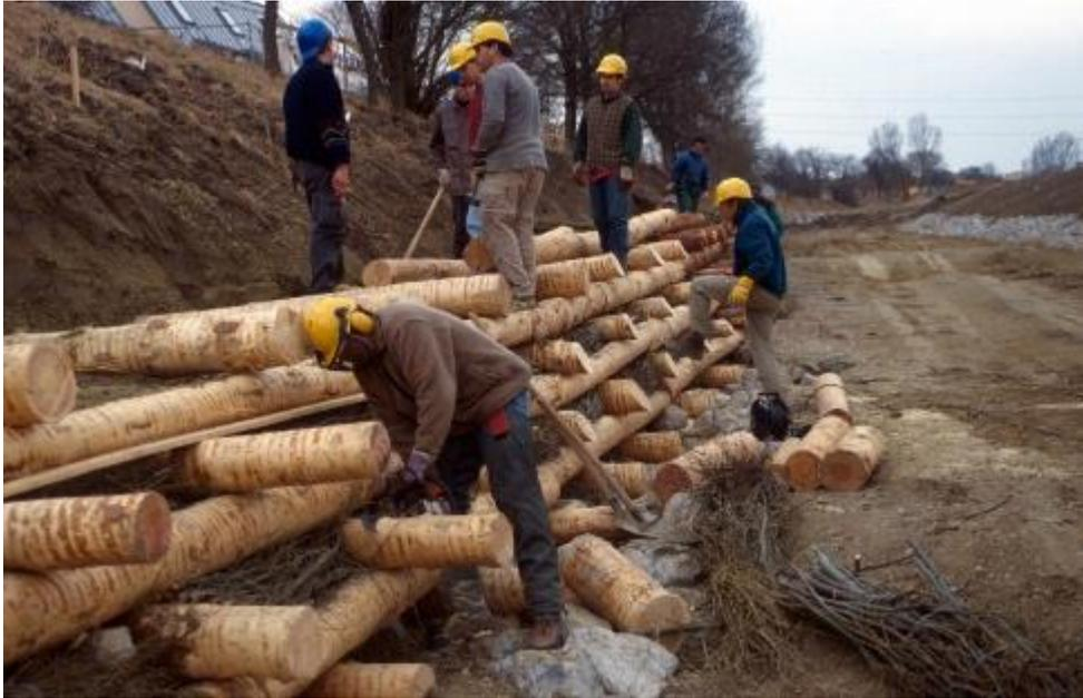
Abbildung 22: Bau einer doppelwandigen Uferkrienerwand
