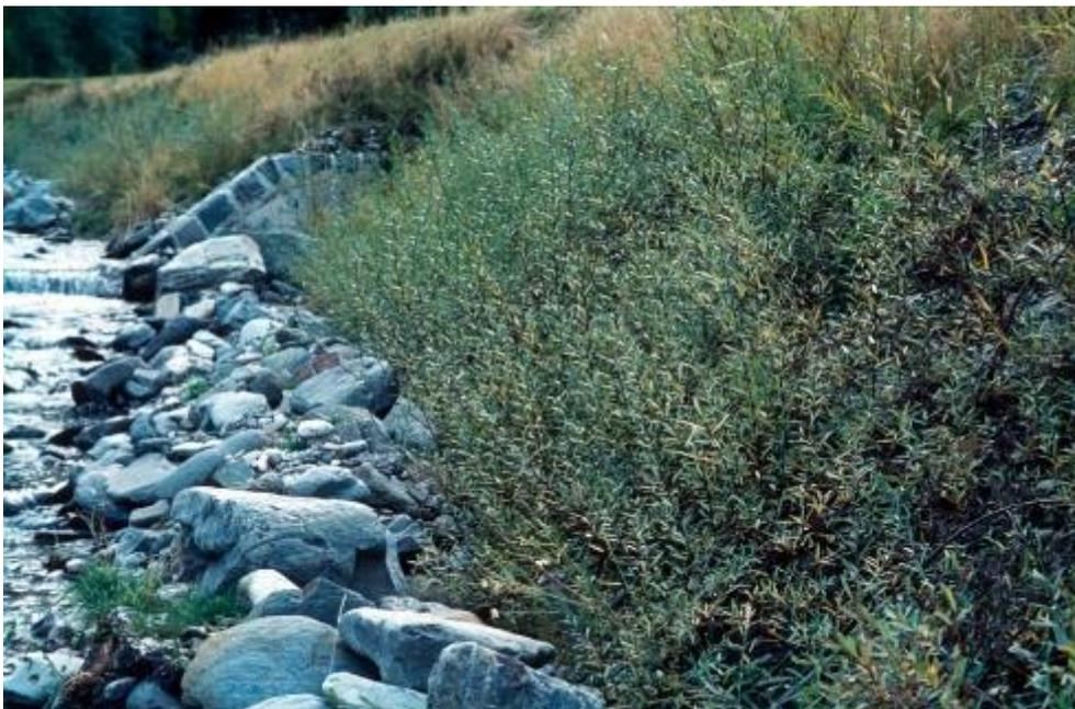
Abbildung 17: Weidenspreitlage 6 Monate nach dem Einbau. Deutlich erkennbar ist auch die zur Sicherung des Böschungfußes errichtete Blocksteinschlichtung
