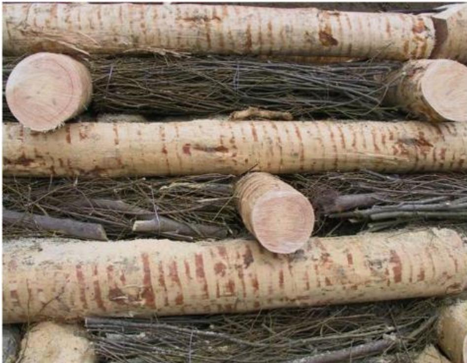
Abbildung 23: Detail einer doppelwandigen Uferkrienerwand aus Lärchenholz mit eingelegten Weidenfaschinen
