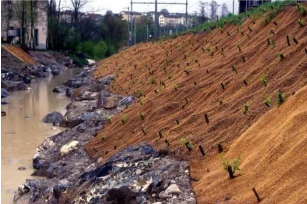
Abbildung 18: Für Begrünungszwecke in die Böschung eingeschlagene Weidensteckhölzer
