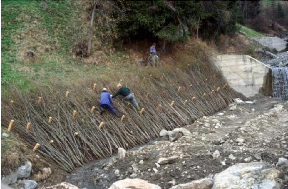
Abbildung 16: Bau einer Weidenspreitlage. Befestigung der quer zur Fließrichtung aufgelegten Weidenäste mittels in die Böschung eingeschlagener Holzpilote und Draht
