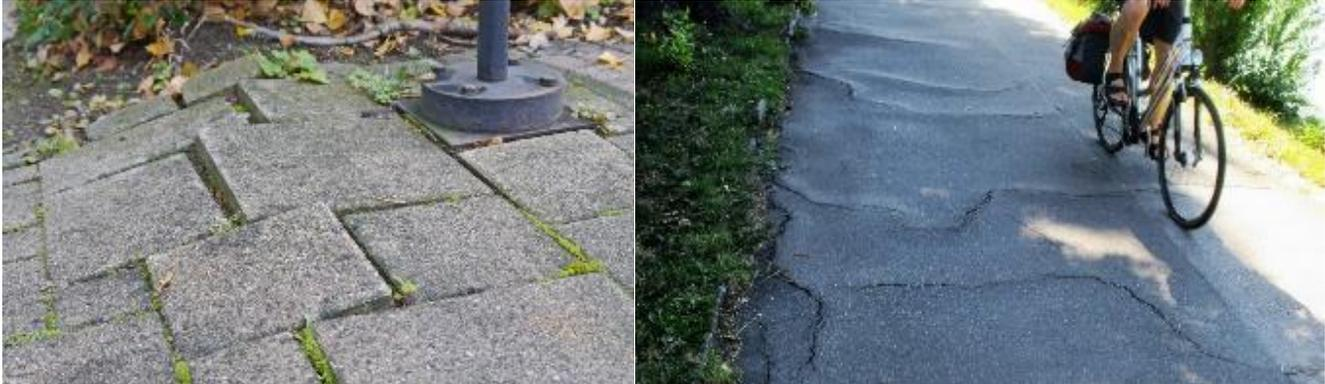
ABBILDUNG 5: ANGEHOBENE ODER VERSCHOBENE PFLASTERSTEINE SOWIE RISSBILDUNGEN IN ASPHALTBÖDEN DURCH BAUMWURZELN (MEIN-SCHÖNER-GARTEN.DE; DRAHTESEL.OR.AT)
