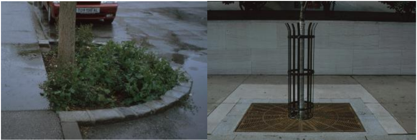
ABBILDUNG 21: LINKS: SCHUTZ DER BAUMSCHEIBE DURCH HOCHBORD UND WURZELBRÜCKE, RECHTS: BAUMROST ALS SCHUTZ VOR BODENVERDICHTUNG
