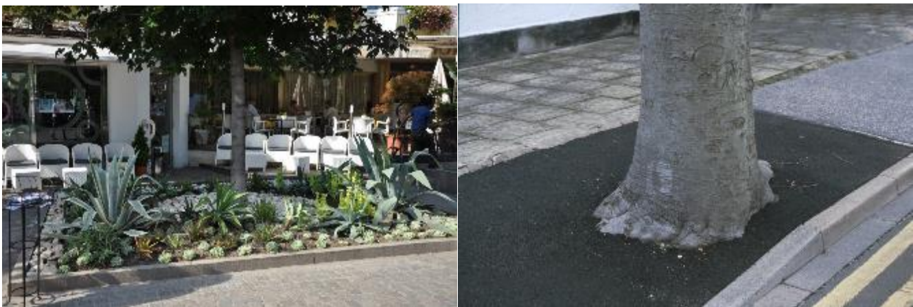
ABBILDUNG 10: ÄSTHETISCHE BAUMSCHEIBENABDECKUNG IN MERAN UND EIN BEISPIEL DAFÜR WIE ES NICHT FUNKTIONIERT
