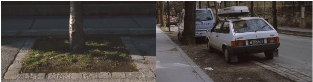
ABBILDUNG 11: MANGELNDE WASSERDURCHLÄSSIGKEIT UND VERHINDERTER LUFTAUSTAUSCH AUF VERDICHETEN BAUMSCHEIBEN (LINKS) UND BODENVERDICHUNG DURCH PARKENDE AUTOS (RECHTS)
